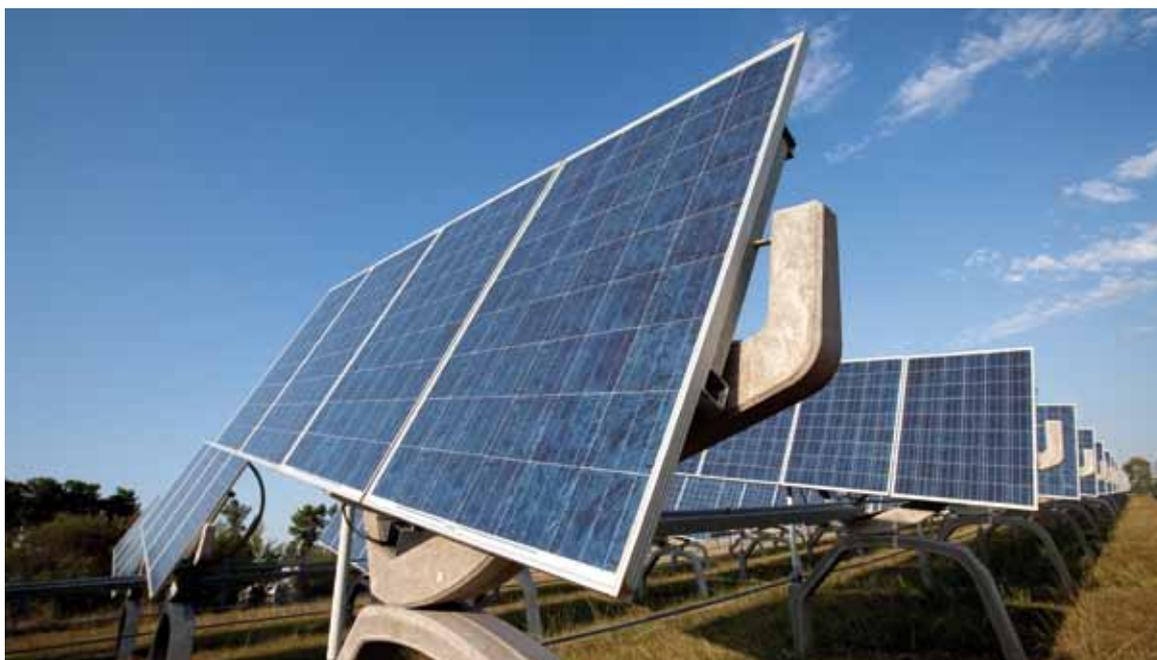
Installation photovoltaïque équipée de suiveurs
