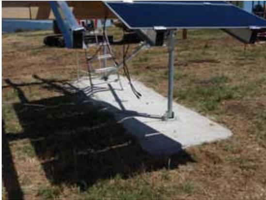
Deux exemples de fondations : fondations avec pieux acier (en haut) et fondations en semelle béton (en bas)
