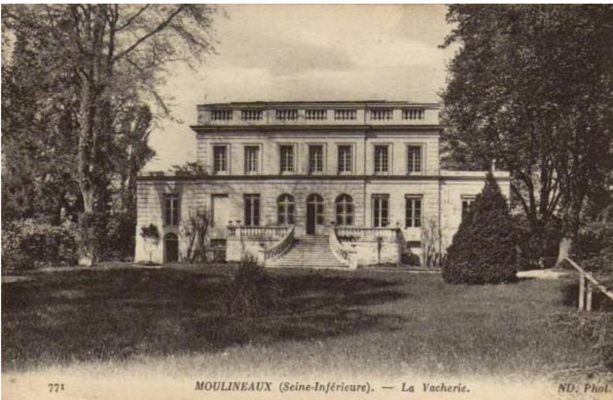
Château de la Vacherie avant démolition par le Port Autonome de Rouen
